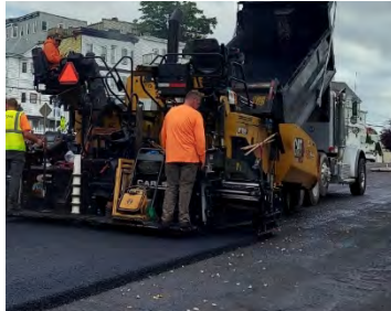
Lát lại các đoạn đường xe chạy bị hư hỏng
