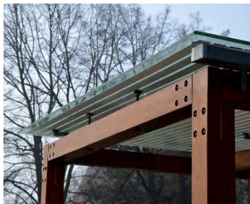
Lắp đặt mái xanh cho nhà chờ xe buýt
