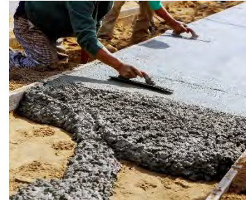
Sửa chữa vỉa hè
