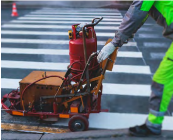
Làm mới lối qua đường và vạch kẻ đường
