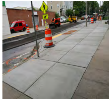
Via Hè Được Sửa Chữa
