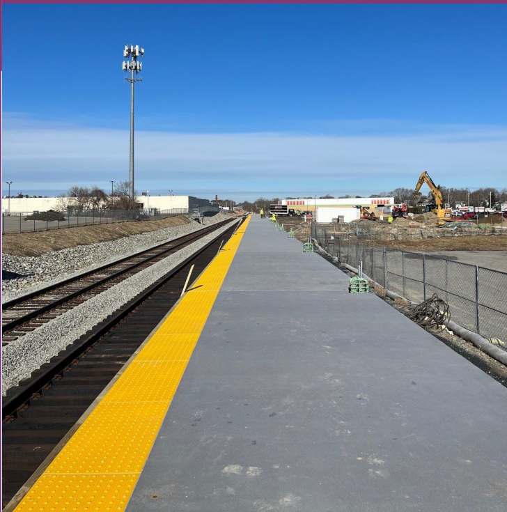
Plataformas de Polímero Reforçado com Fibra de Vidro (PRFV) na Estação de Church Street em New Bedford, Fevereiro de 2023
