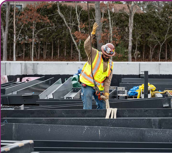
Instalação das plataformas na Estação de East Taunton, Fevereiro de 2023
